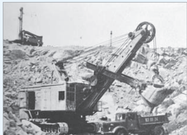
Так выглядела погрузка экскаватором горной массы в автомобили в первые годы эксплуатации комбината...
